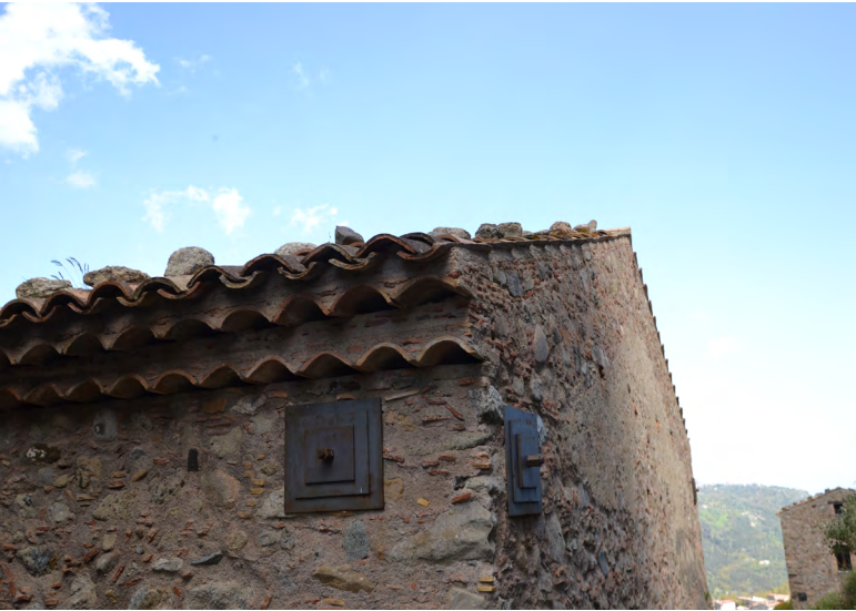
Foto 67 – Particolare della copertura ricostruita della Chiesa di San Giovanni Battista
