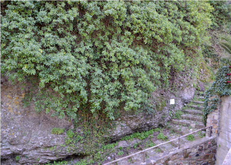
Foto 44 – Scalinata di collegamento tra il Ponte di Santa Caterina e il nuovo ponte su Via Gorizia
