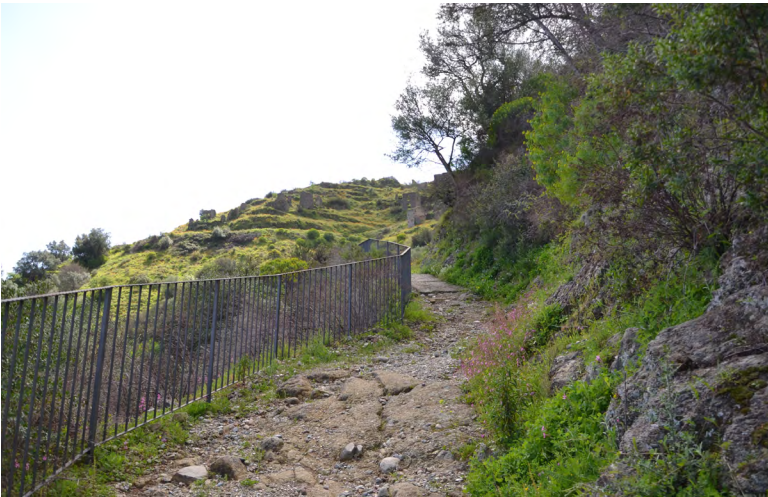
Foto 82 – Percorsi di collegamento dissestati
