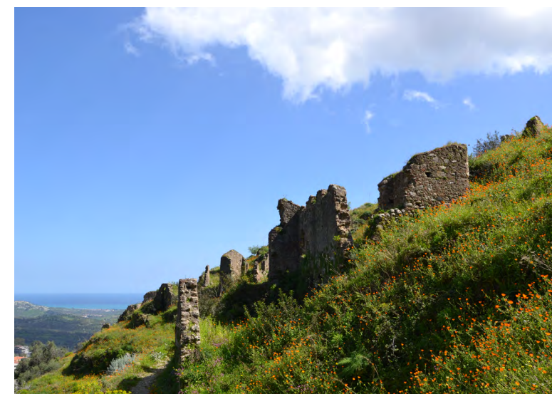
Foto 18 – Ruderì non oggetto di intervento
