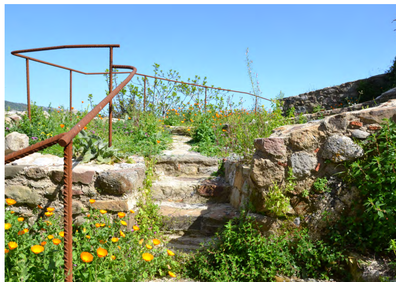
Foto 23 – Percorsi soggetti ad intervento recente
