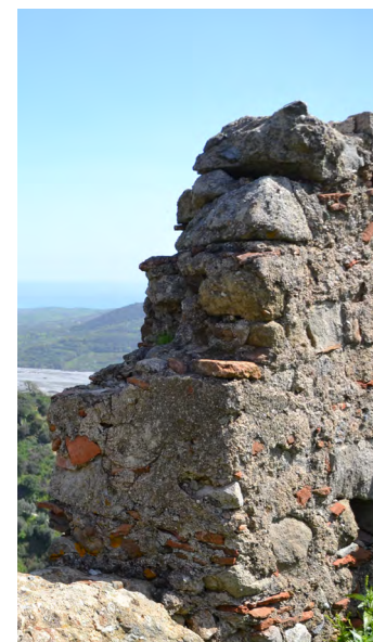
Foto 30-31-32 – Murature originarie, con composizione mista pietra-laterizio, evidenza di preesistente intonaco e buche pontaie
