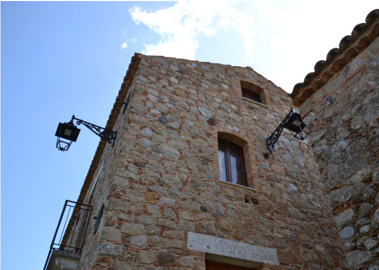
Foto 66 – Particolare della c.d. “Casa Baronale” ricostruita, con architravi in materiale lapideo
