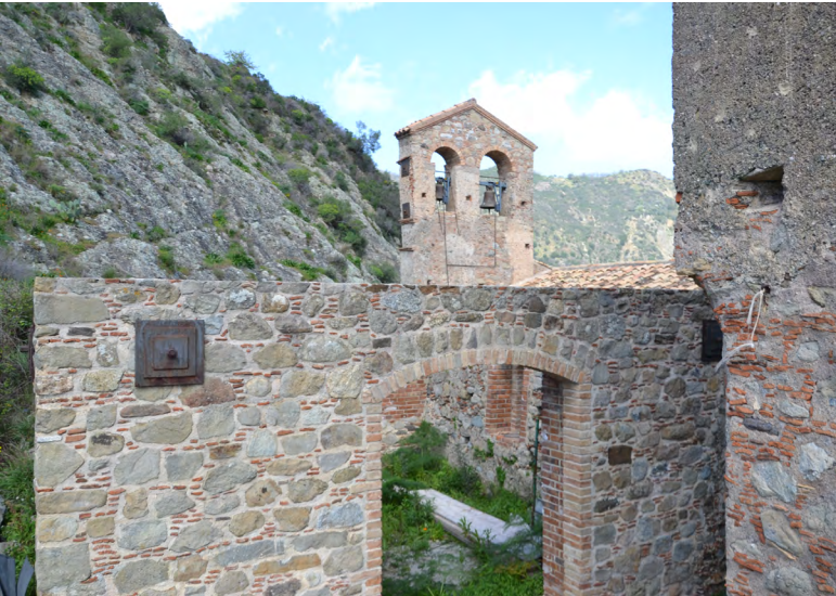
Foto 65 – Particolare di muratura ricostruita con tecnica incoerente rispetto alla tradizione locale
