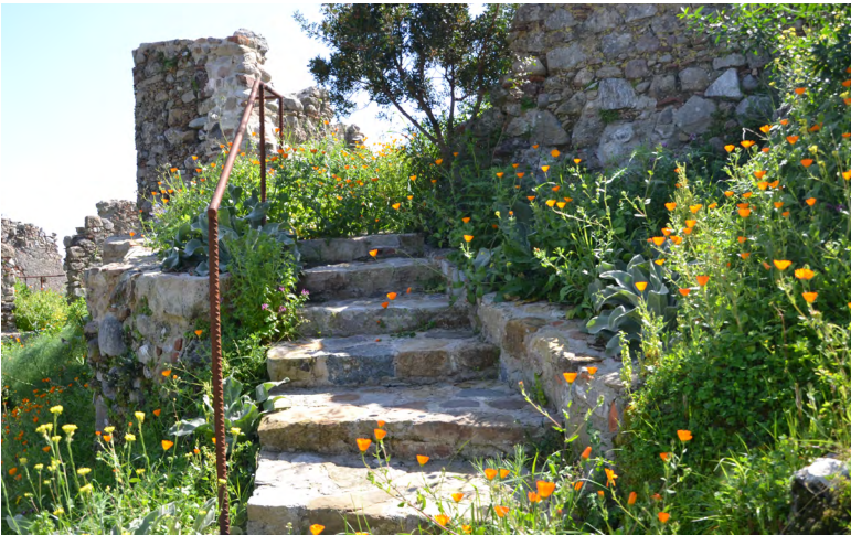
Foto 76 – Utilizzo di materiale cementizio per il rifacimento dei percorsi e delle scalinate tra i ruderi
