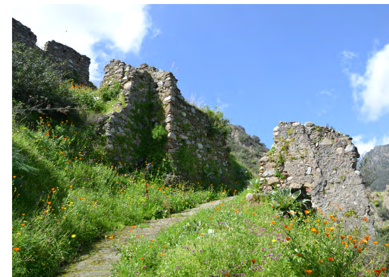
Foto 17 – Ruderì non oggetto di intervento
