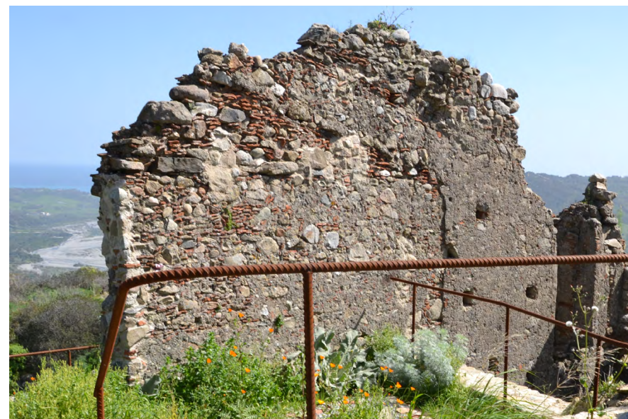
Foto 30-31-32 – Murature originarie, con composizione mista pietra-laterizio, evidenza di preesistente intonaco e buche pontaie
