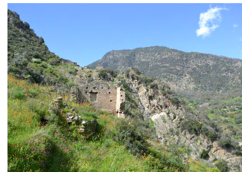
Foto 19 – Ruderì non oggetto di intervento
