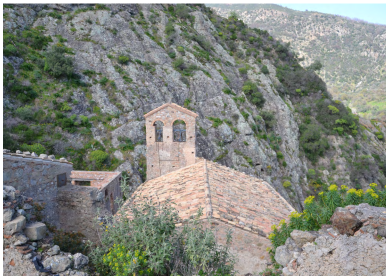
Foto 70 – Copertura ricostruita della Chiesa di San Giovanni Battista
