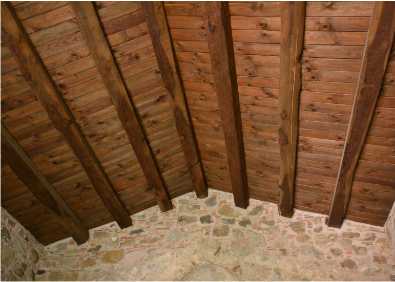
Foto 68 – Particolare della struttura lignea della copertura della Chiesa di San Sebastiano
