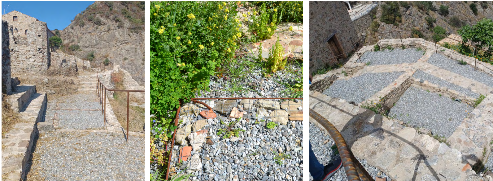
Foto 40-41-42 – Interventi recenti: posa di parapetti in acciaio lungo i percorsi e di geotessile e ghiaia all’interno dei ruderi (prima e terza immagine su gentile concessione del Sig. Sindaco di Samo, Paolino Pulitanò)
