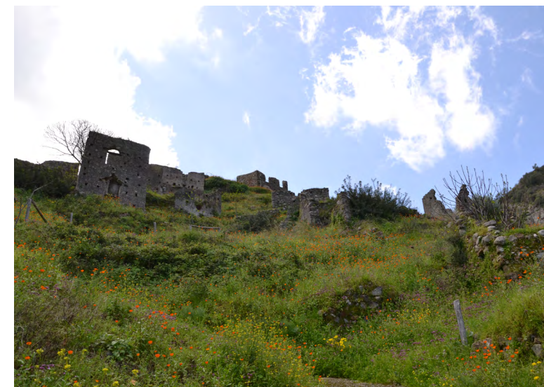
Foto 16 – Ruderì non oggetto di intervento
