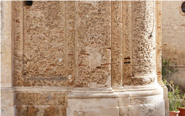
PARAMENTO MURARIO DELLA CHIESA DEL SACRO CUORE
