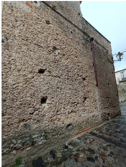
PARAMENTO MURARIO SUL RETRO DI PALAZZO CANDIDO
