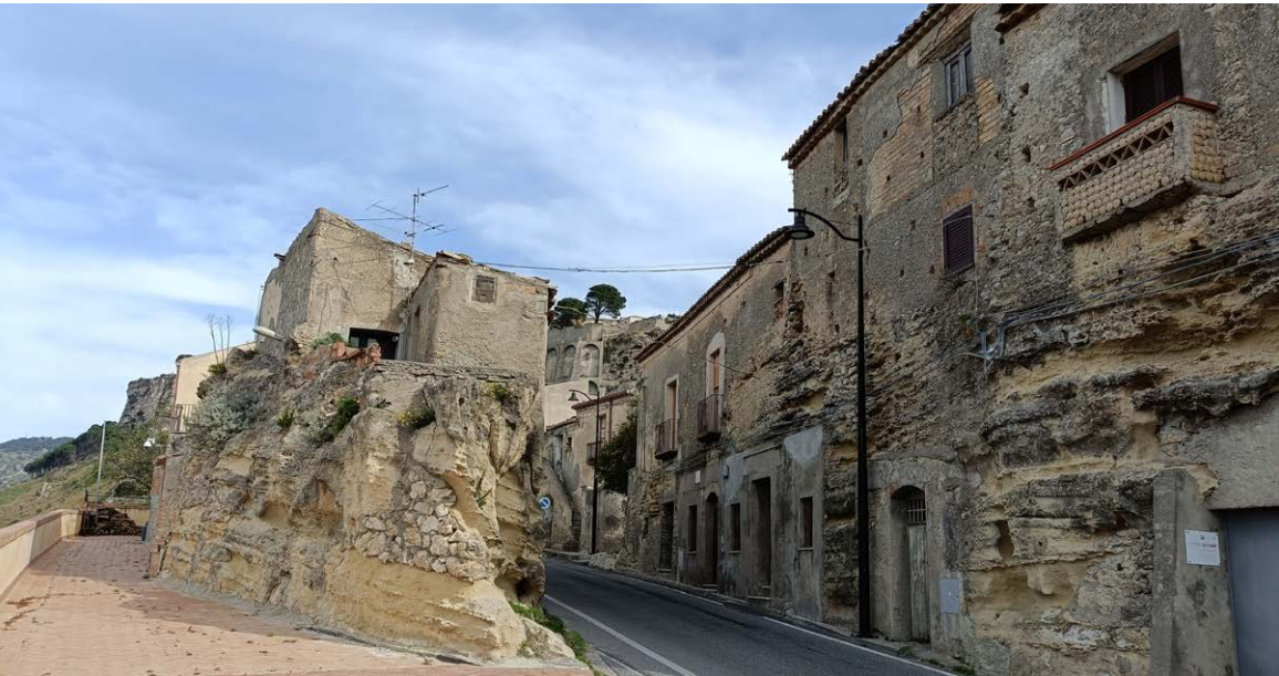
Fig. 26 - Fabbricati scavati nella roccia Soluzioni costruttive parzialmente ipogee, nelle quali il piano terra è ricavato scavando nella roccia e i piani superiori vengono costruiti come sopraelevazioni.
