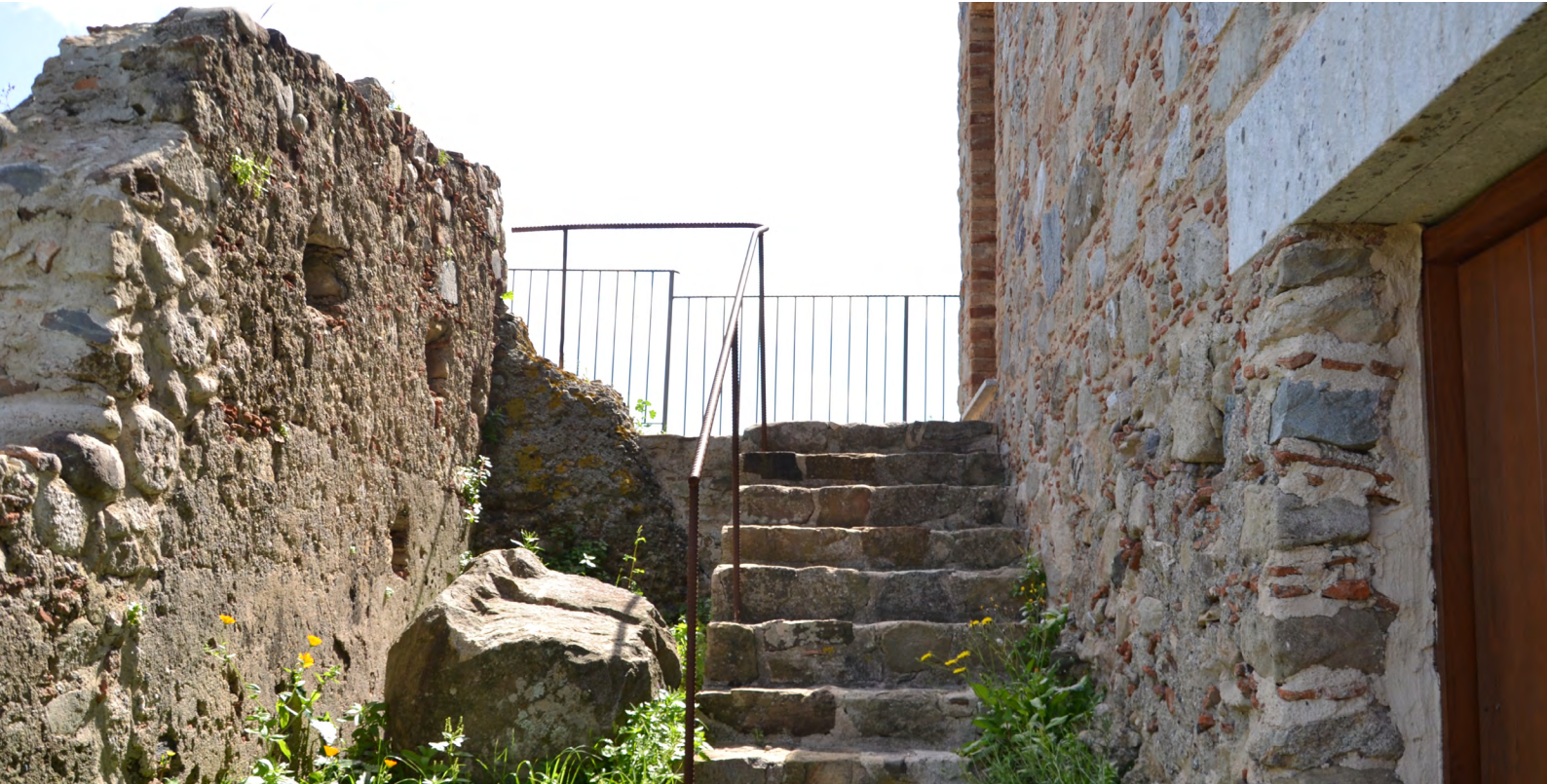
Fig. 2.a – Confronto tra muratura originaria (a sinistra) e muratura sottoposta ad intervento (a destra) La muratura originaria è caratterizzata da aspetto grezzo e irregolare, composizione mista pietra-laterizio e mostra, sulla propria superficie, tracce del preesistente intonaco e presenza di buche pontae; la muratura dell'edificio sottoposto a ricostruzione (cosiddetta "Casa Baronale") mostra un intervento non coerente con la tradizione locale, poiché presenta superficie resa uniforme, con piano "a piombo", orizzontamenti regolari e cocci in laterizio applicati in superficie, con funzione decorativa.
