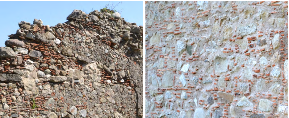
Fig. 2.a – Confronto tra muratura originaria (a sinistra) e muratura sottoposta ad intervento (a destra) La muratura originaria è caratterizzata da aspetto grezzo e irregolare, composizione mista pietra-laterizio e mostra, sulla propria superficie, tracce del preesistente intonaco e presenza di buche pontae; la muratura dell'edificio sottoposto a ricostruzione (cosiddetta "Casa Baronale") mostra un intervento non coerente con la tradizione locale, poiché presenta superficie resa uniforme, con piano "a piombo", orizzontamenti regolari e cocci in laterizio applicati in superficie, con funzione decorativa.
